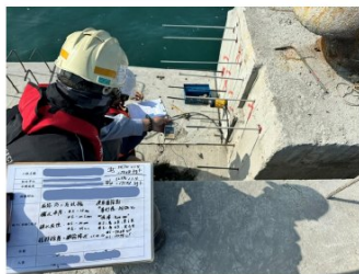
知道在哪裡，看到施工全貌
